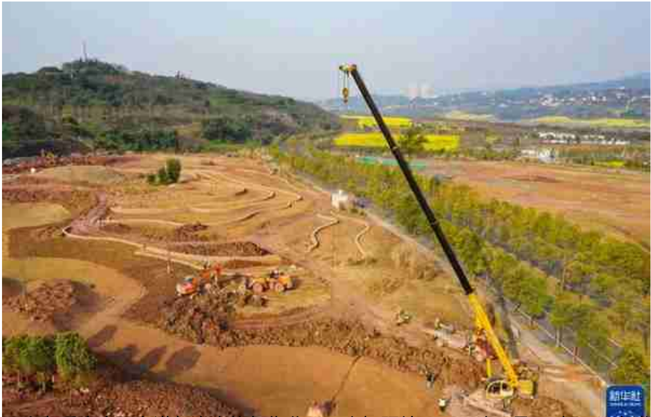
工人在重庆广阳岛进行生态修复作业（无人机照片，2020年3月6日摄）。新华社记者 王全超 摄
