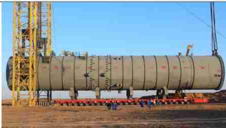
图表 20 费托合成反应器
